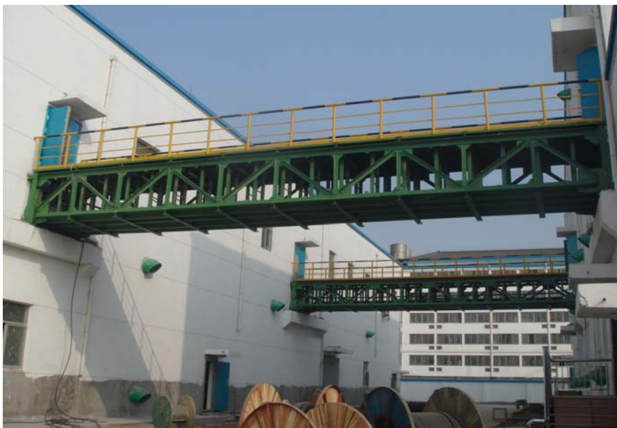
图 3 3#建筑物与 2#建筑物之间连接的二座钢结构天桥
